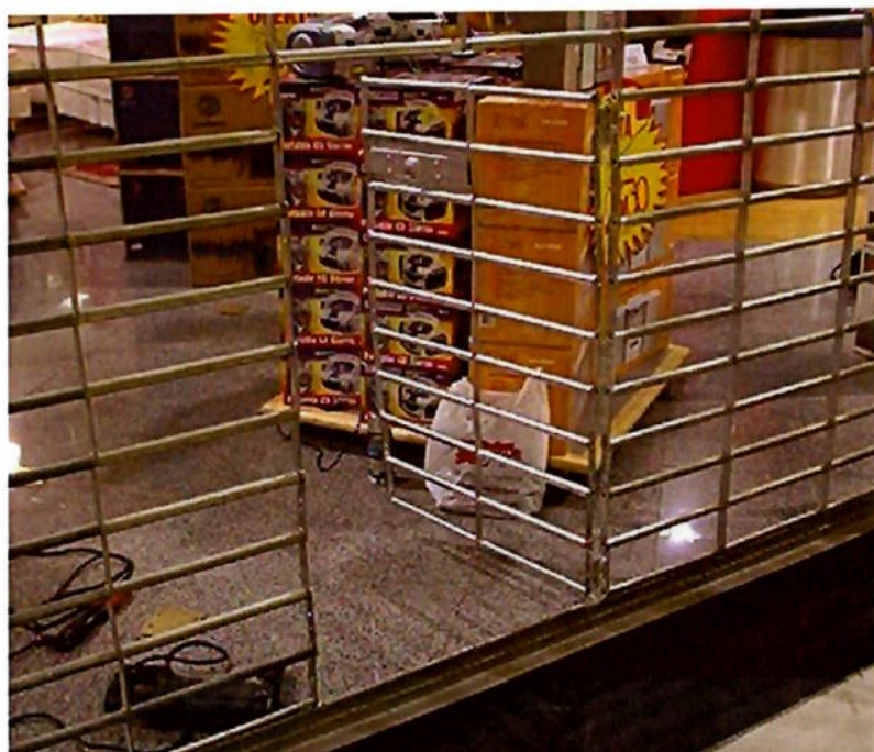
Fig. 31 – portinhola vertical retrátil
