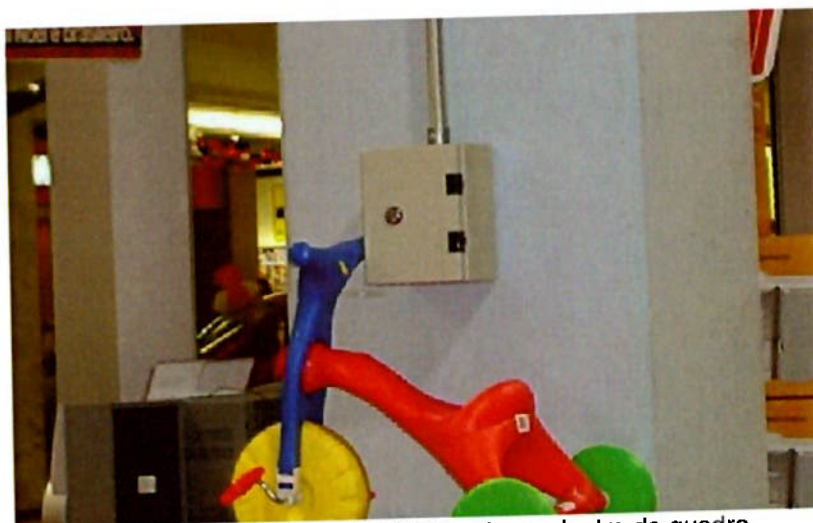
Fig. 28 – reinstalação dos interruptores dentro do quadro
