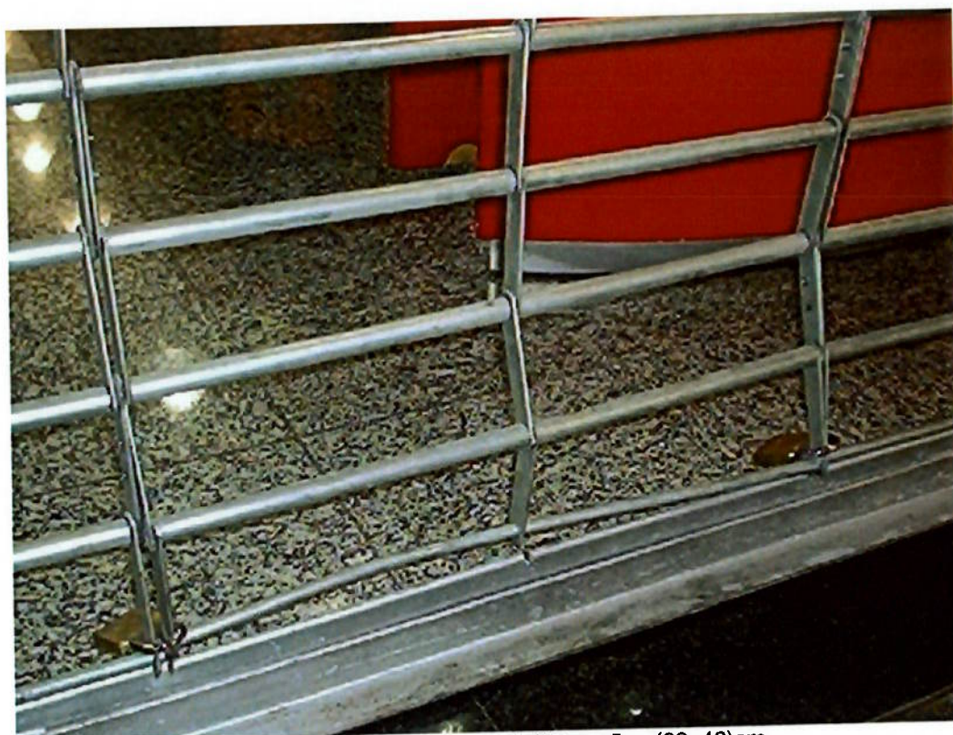
Fig. 13 – portinhola horizontal dimensões (62x46)cm.
